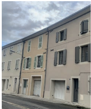
Enduits grattés de teinte ocrée avec encadrements de fenêtres peints, génoises conservées et peintes
