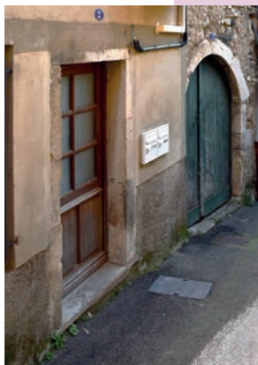
Porte d'entrée et porte de grange en bois
