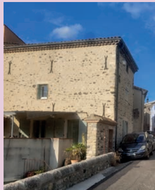
Enduit à pierre vue
