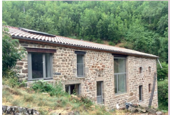
Linteaux métalliques, David Grimaud architecte
