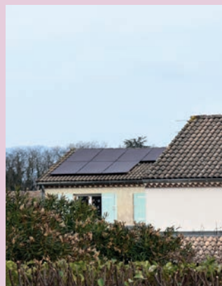
Pose de panneaux solaires de teinte brune sur du bâti récent
