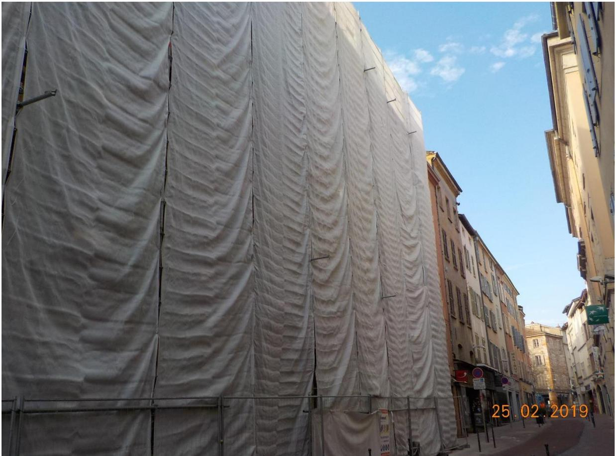
**Figure 18. Exemple de protection périphérique qui peut être mise en œuvre.**
