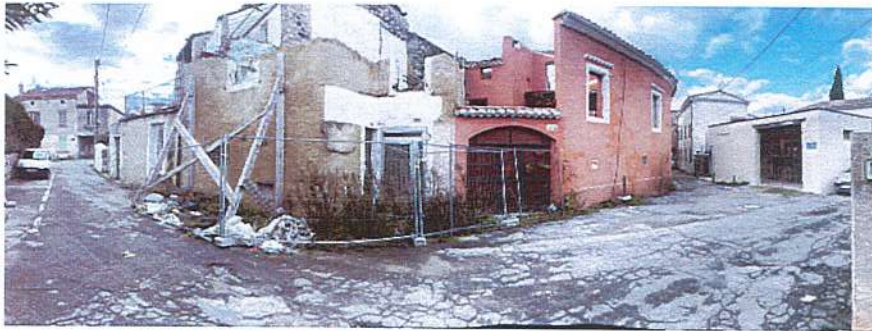
Photographie de l'îlot Robespierre avant les démolitions
