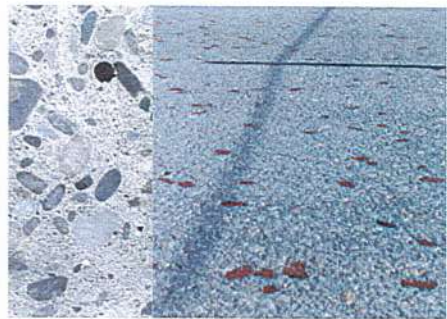
Béton avec incrustations
