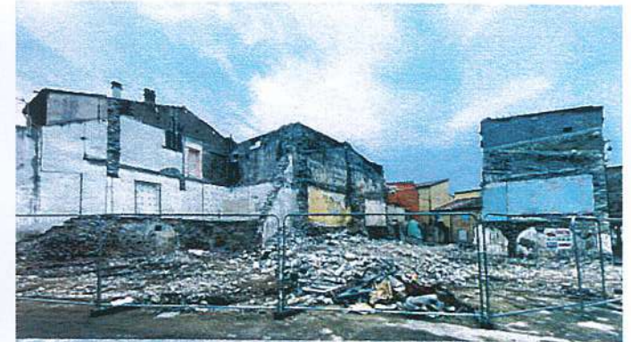
Démolitions sur l'îlot Robespierre, peu de matériaux laissés en place
