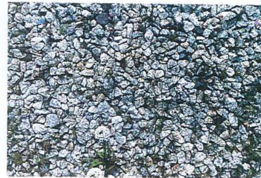
Images de références - stationnements en mélange terre/pierre réalisés par l'Atelier L. Paysage à Jaujac
