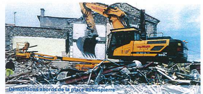
Démolitions abords de la place Robespierre
