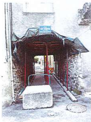
Colonne centrale - des démolitions attendues et un gisement pour le projet.
